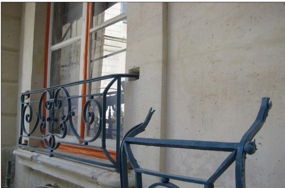
Les balcons en fer forgé ont fait l'objet d'une dépose suivie d'une complète restauration en atelier de ferronnerie (remplacement des éléments manquants).
