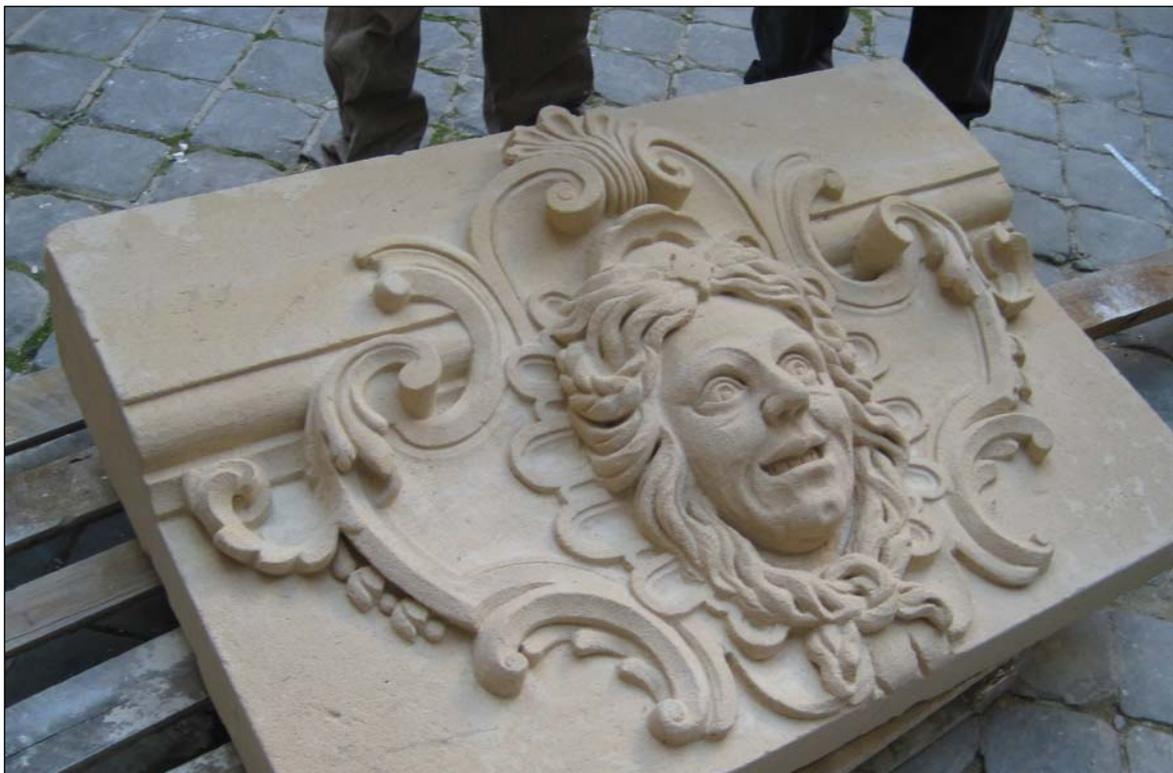
Le mascaron en pierre entièrement refait à la main est livré dans la cour. C'est un bloc de pierre de plusieurs centaines de kilos qui doit être monté et fixé sur la façade.
