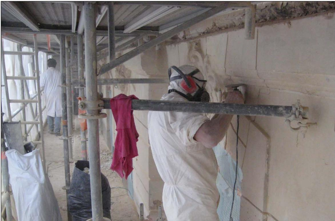
Vues du chantier depuis les échafaudages (façade Sud). Les mascarons, corniches, consoles, appuis de fenêtres, apparaissent à nu après décapage de quelques 15 couches de peinture.
