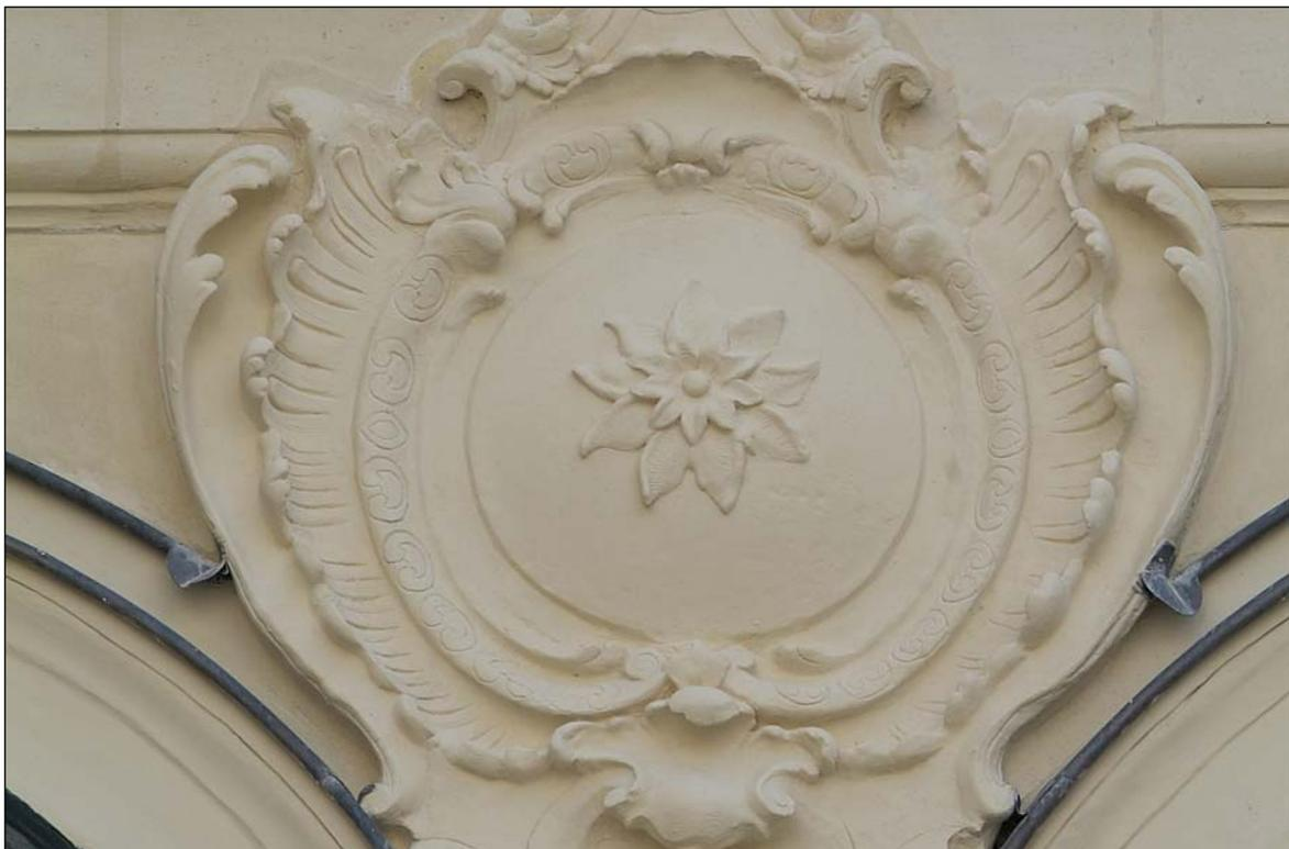
Mascaron n°9 en façade ouest (plâtre, très abîmé). Remplacé à l'identique par un mascaron en plâtre après moulage en silicone, restauration du moule et tirage.
