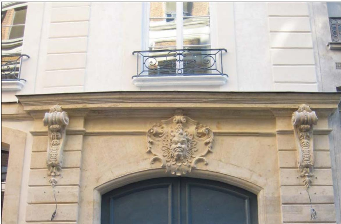
Les trois fenêtres sur rue après leur remise en état. Les montants de ces fenêtres, très détériorés au cours des siècles, ont été entièrement repris et remplacés par des montants en pierre. En-dessous, l'état du porche, mascaron central et consoles, quelques instants après la dépose des échafaudages.
