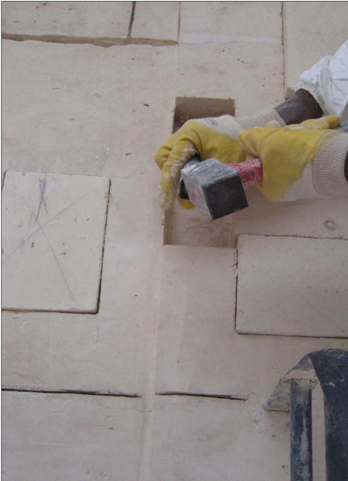
Taille et pose des bouchons de pierre sur les façades. De nombreux accidents apparaissent lors du décapage des façades, et la pose de “bouchons” s’avère nécessaire sur l’ensemble d’entre elles.
